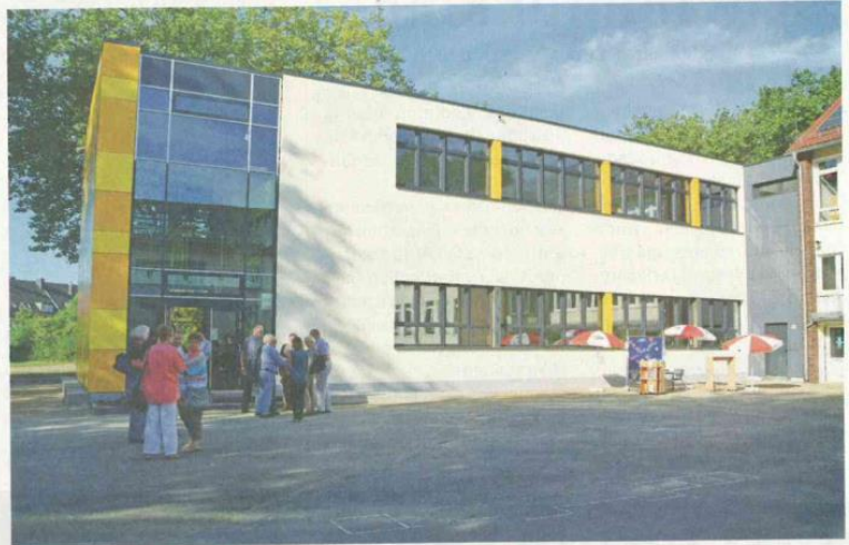
Endlich gibt es an der Ludgerusschule ausreichend Platz. Der Neubau an der Birkenstraße wurde termingerecht fertig.
